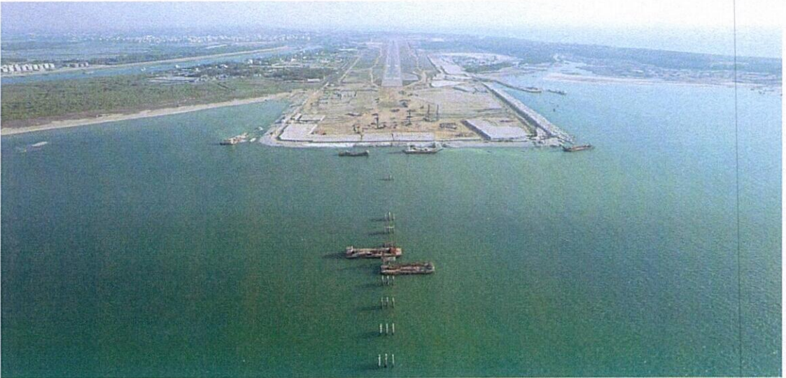
কক্সবাজার বিমানবন্দরের রানওয়ে সম্প্রসারণ প্রকল্পের বর্তমান অবস্থা
